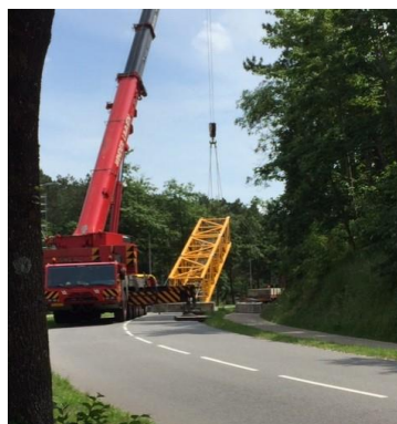
Foto 2: de gele kraan wordt weer afgebroken
